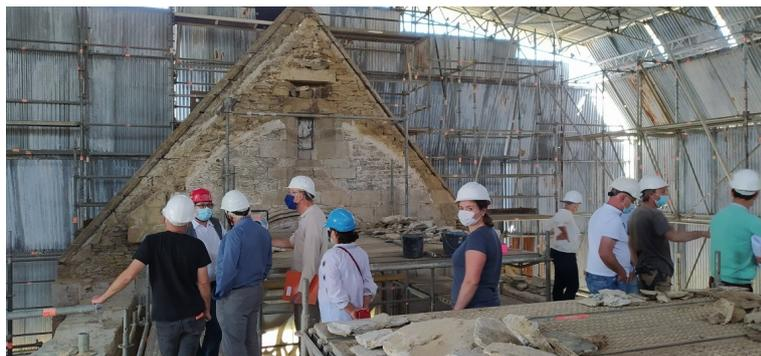
Le chantier de réhabilitation de l'église a repris mi-mai après une interruption de 2 mois due au coronavirus. La charpente est en rénovation dans les ateliers de l'entreprise Asselin à Thouars (49). Sa dépose a mis en lumière des "anomalies" de construction sur la structure (différence de niveau Nord-Sud de 20 cm, ...) qui sont en cours de rectification (cf photo du pignon).
